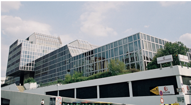
Unterschiedliche Sicherheitsanforderungen, verschiedene Ausweise und Leser: Dank Kaba exos alles unter einem Dach.
